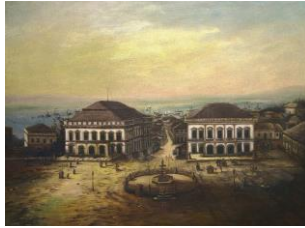
Imagem 2: Prédio da Câmara Municipal (à direita) e Theatro São Pedro (à esquerda).
